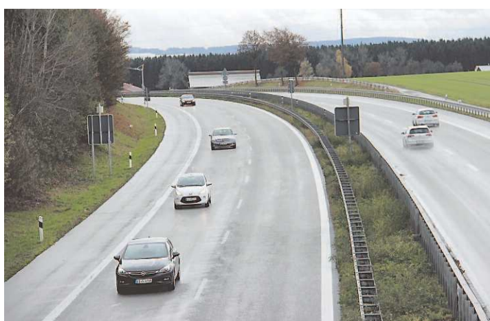
Die westliche Fahrbahn der Schnellstraße wurde 2011 saniert, in diesem Jahr kommt die östliche Fahrbahn dran.
